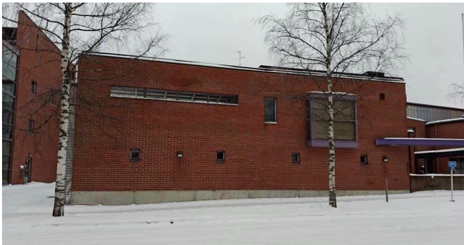
Kuva 39. Sivurakennus: henkilökunnan saunatiloja Jääkärinkadulta.
