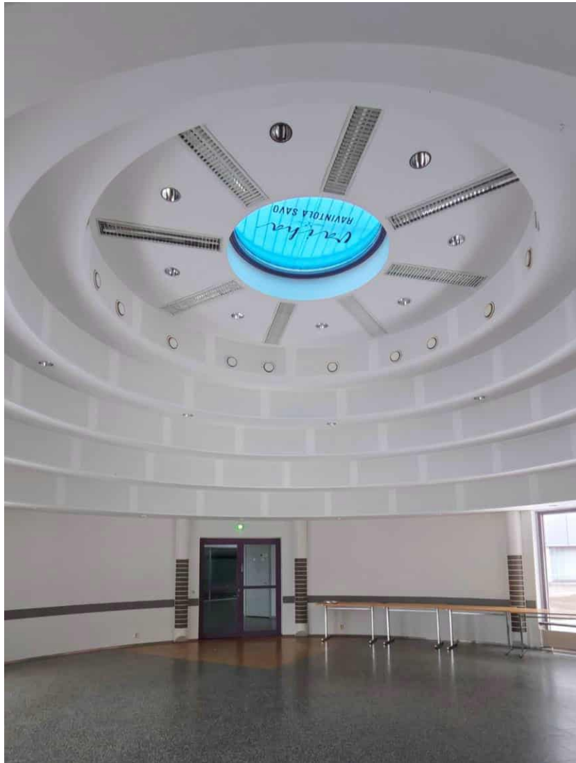
Kuva 47. Ruokasalin katto muodostuu keskeisesti järjestetyistä, päällekkäisistä kaarevista pinnoista, jotka luovat kupolimaisen rakenteen ja nousevat yläosan kattoikkunaa kohti.
